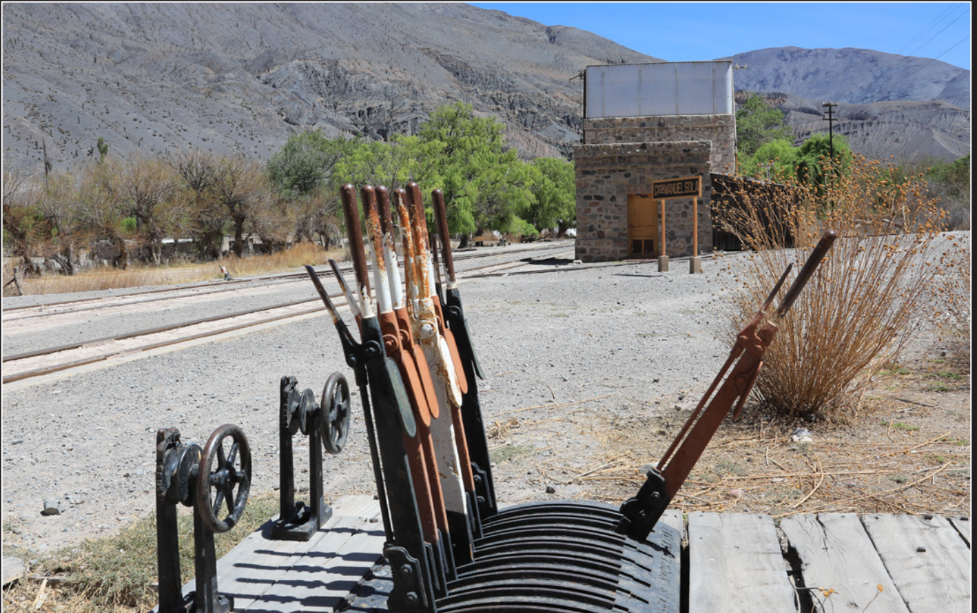
▲ Gdor. M. Sola: Hebelbank von Tyer & Co. Ltd. aus Großbritannien
